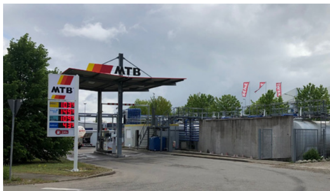
Weithin sichtbar: an der neuen MTB-Tankstellen gibt es neben klassischen Diesel auch GTL-Fuel und R33.
