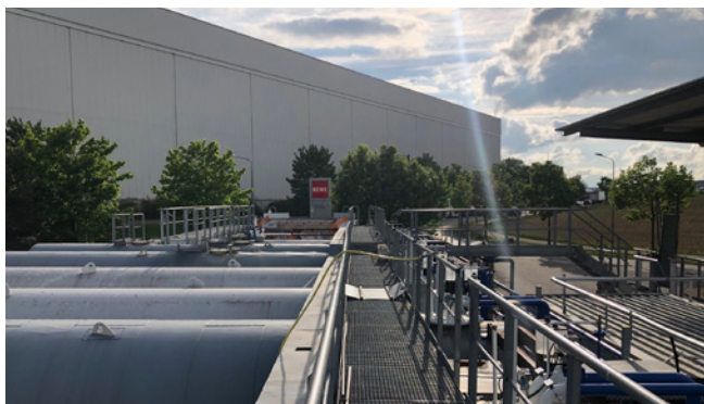
Anfang Mai 2020 war der Umbau des Lagers abgeschlossen.
